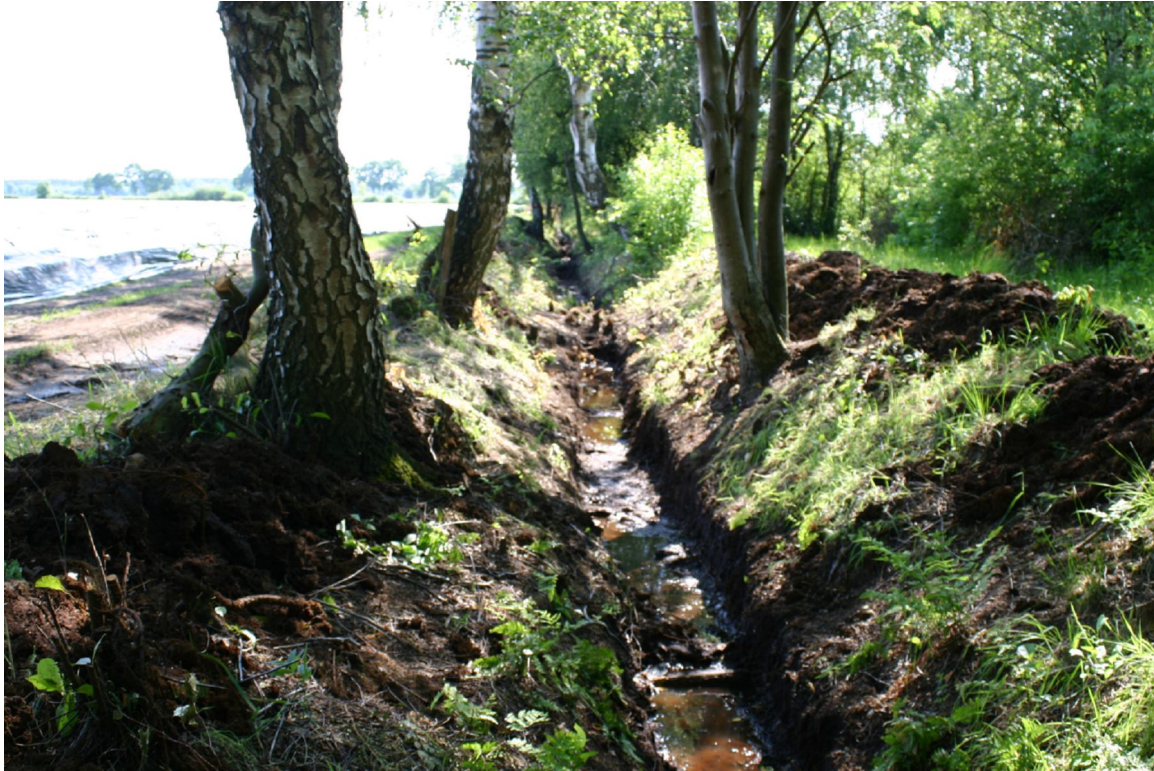
2009.05.23 Grenzgraben am Naturschutzgebiet Lichtenmoor Im Aufsichtsbereich des Unterhaltungsverbandes Alpe-Schwarze Riede werden Sohlvertiefungen und Rodungsarbeiten ausgeführt.
